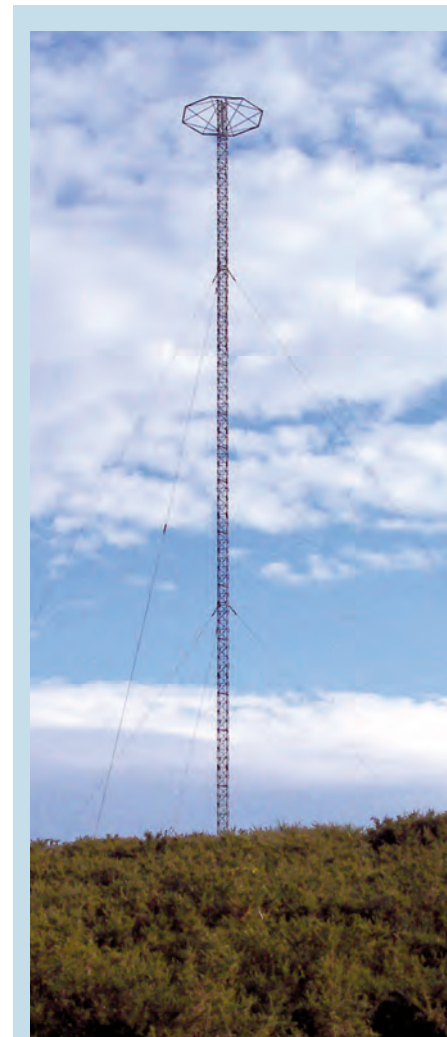
1940. Unha das tres torres de comunicacións do sistema Elektra Sonne instalado entre Abadín e Cospeito (Lugo), cando aínda estaba en pé
